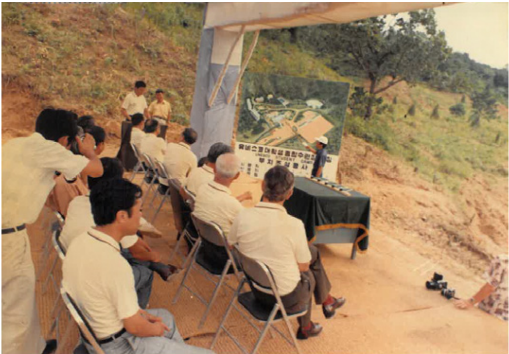
‘유네스코 대학생 종합수련장’ 정지공사 기공식 현장 1974. 8. 1.
