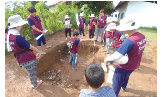
| 라오스 워크캠프 노력봉사 모습. 워크캠프 기간동안 정화조 2동과 실링팬 12기를 설치하였다.(1,464,330 KRW 상당)
