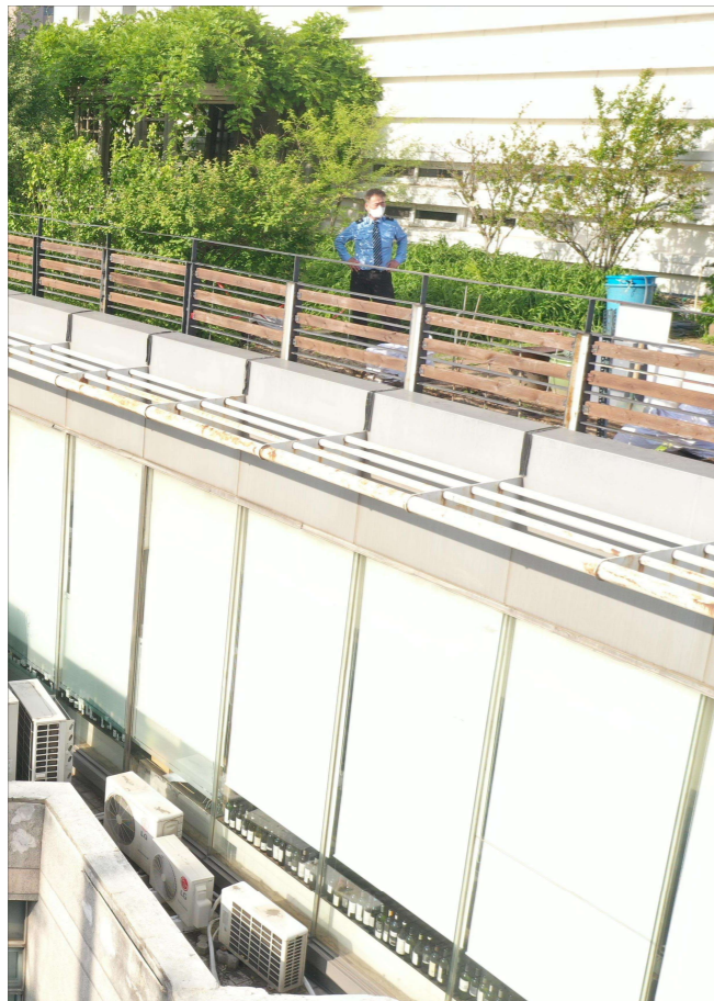
외부 난간 보수 및 마감재료 세척
