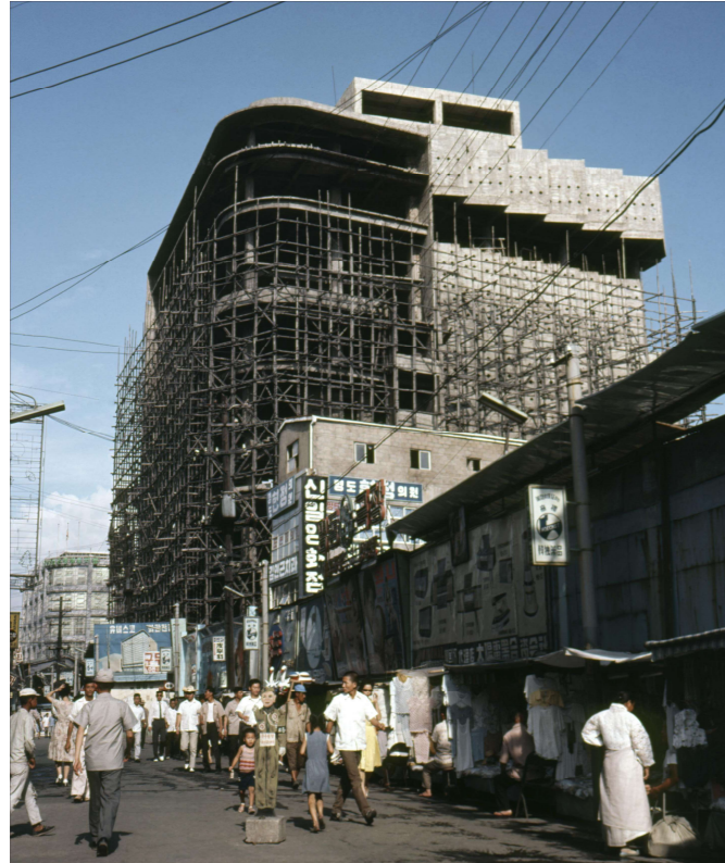
서울(상업은행 공사 현장)
