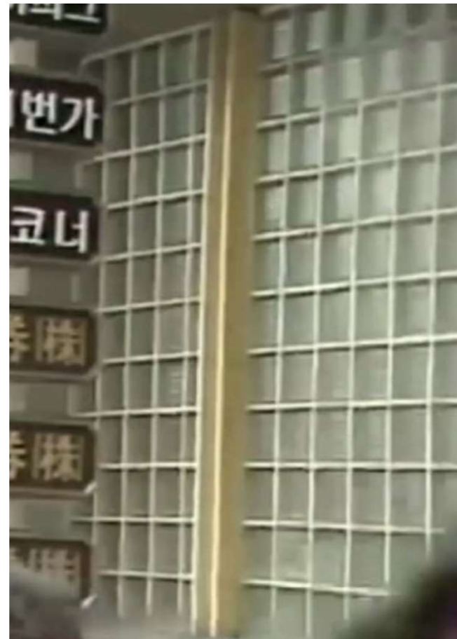
마감재료 복원 - 유리블록 입면
