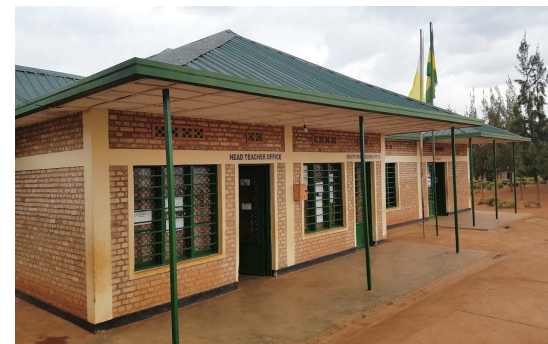
1 건축 중인 부게세라 카부무 마을의 우루무리 지역학습센터 모습 (2018.4월 당시) 2 완공된 우루무리 지역학습센터 전경(2018.11월)
